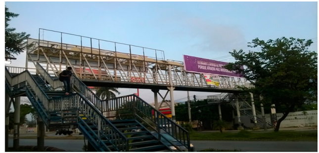
Figura 4. Puente peatonal en el Boulevard Belisario Domínguez frente al Campus I de la UNACH (Nuriulú, 2017).
